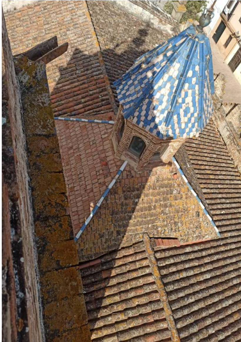
El cimbori edificat sobre la teulada l'any 1611.
