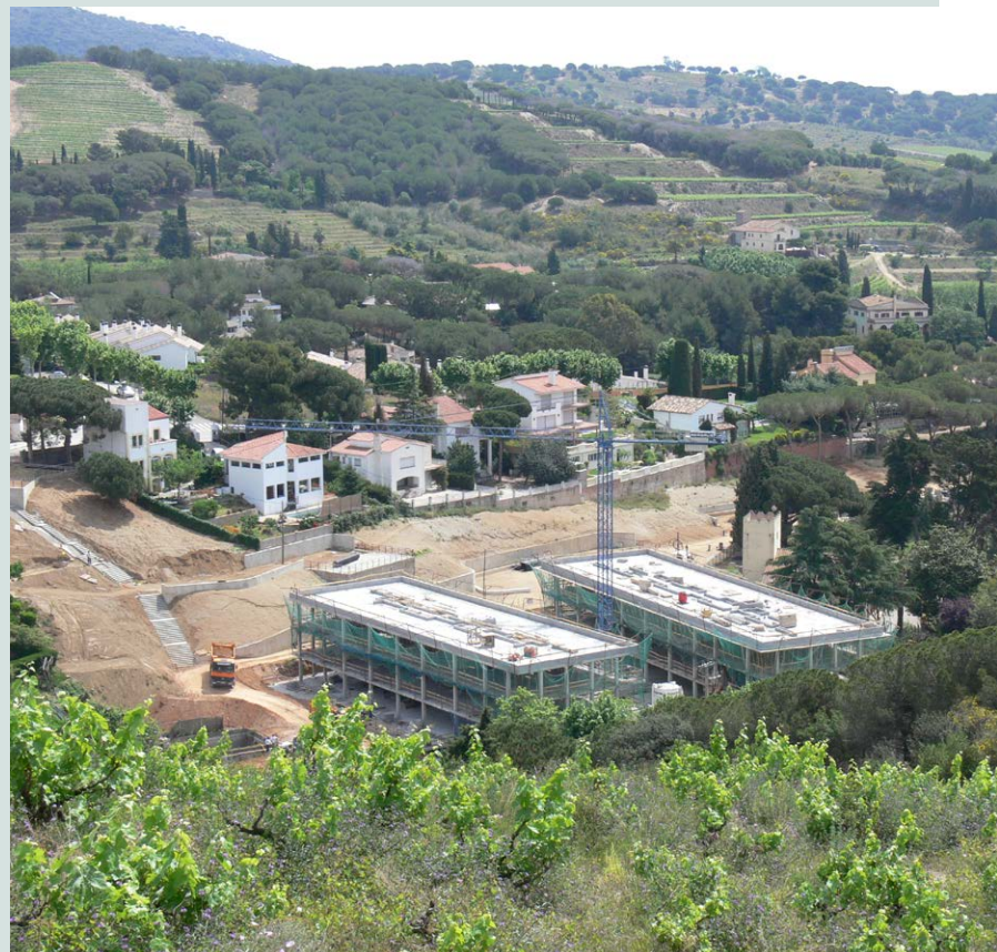
Imatge de les obres dels pisos socials de Cal Doctor, l'any 2008.
