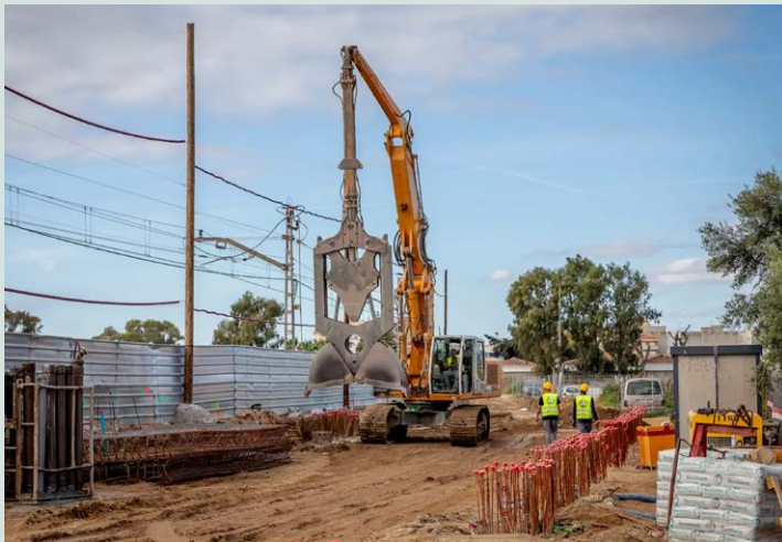
Obres a l'àmbit del pla de Balasc.
